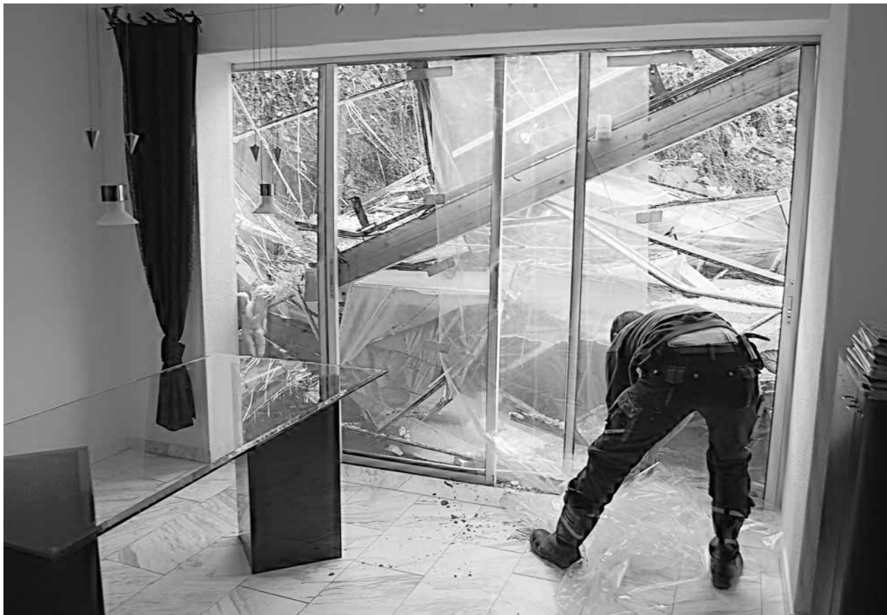
Durch den Erdbeben von letzter Woche an der Schwyzerstrasse wurde der Wintergarten von Petra Baumgärtner und Marc Richardet völlig zerstört.
